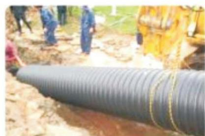
内肋增强聚乙烯(PE)螺旋波纹管
