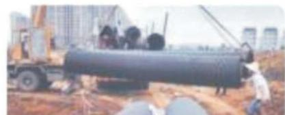
钢带增强聚乙烯(HDPE)螺旋波纹管
